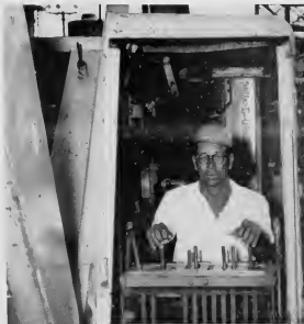
ERASMUS at controls of crane F-15 guides free end of stack. ERASMUS na controlnan di grua F-15 ta guia e punta suelta di e staca.
